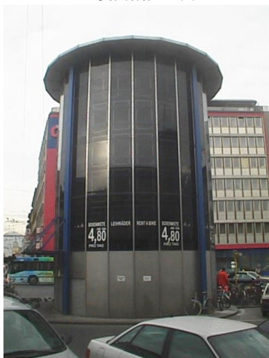
Velomat am Hauptbahnhof in Innsbruck 7 Decks mit jeweils 23 Radstellplätzen, insg.161 Radstellplätze beherbergt diese Velostation.
